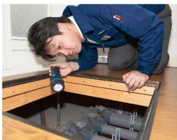
基礎の状態やシロアリ被害の有無などを調査
