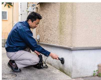
基礎に鉄骨筋が入っているか調査
